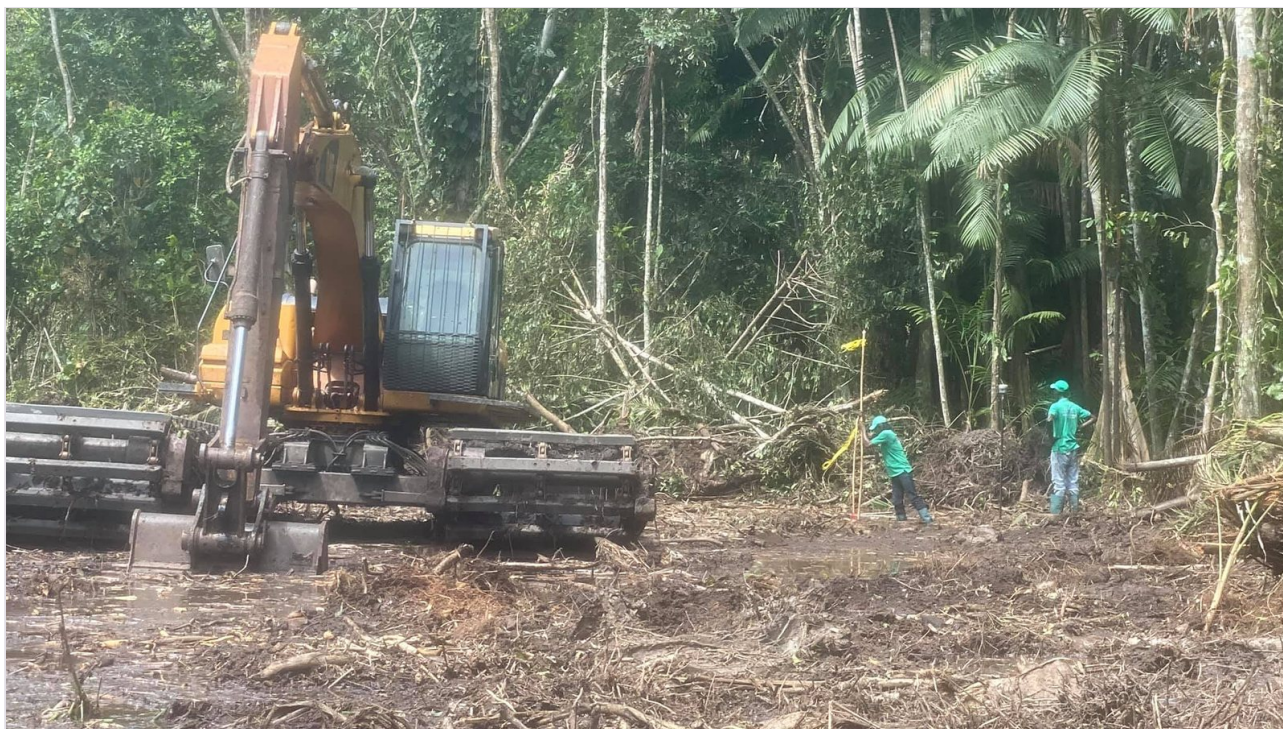
Grondwerk in uitvoering.
